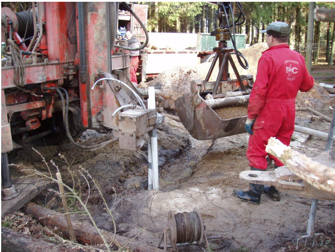
Figur 1. Udbygning af boring. I dette tilfælde er der to forerør i samme hul.
