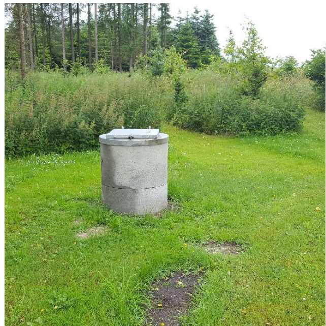
Figur 5: Udbygget boring med aflåst beskyttelse. Bemærk der er monteret et sikkert, men let låg. Til venstre en principskitse.
