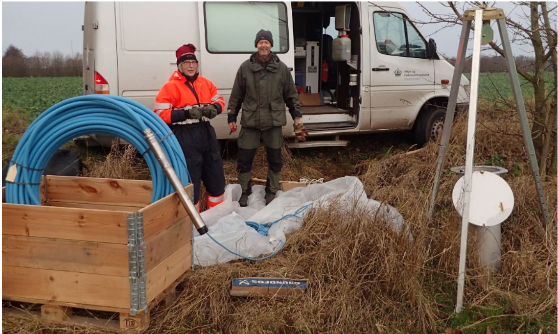
Figur 7. Forberedelse af montering af større elektrisk dykpumpe og slanger. Udstyret er samlet i forvejen på værkstedet, hvor længden af slangerne er afpasset boringens tekniske indretning.
